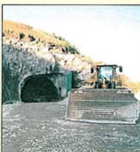
Innlagt på Stallogargoflågan på Hammerfjellsiden. Tunnelgjengen fra Nordland fyrte av den første salva 16. juni. Foto: Mari-Ann Ekren
