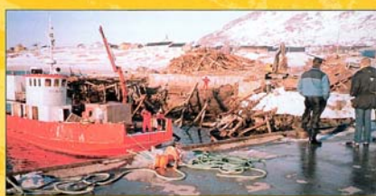
Hustadbrukets tilhørende kaiareal måtte også rives for å lage plass til den nye fergekaia med landareal. Arbeidet ble utført av "Domen".
