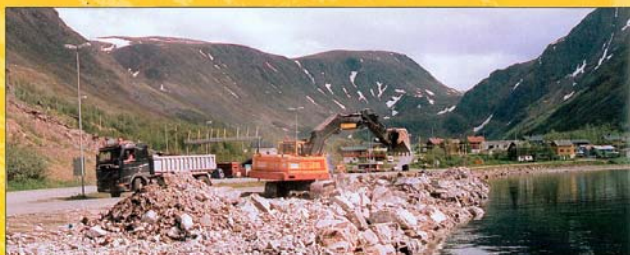
Utfyllingsarbeider ved fergekaia i Øksfjord.
