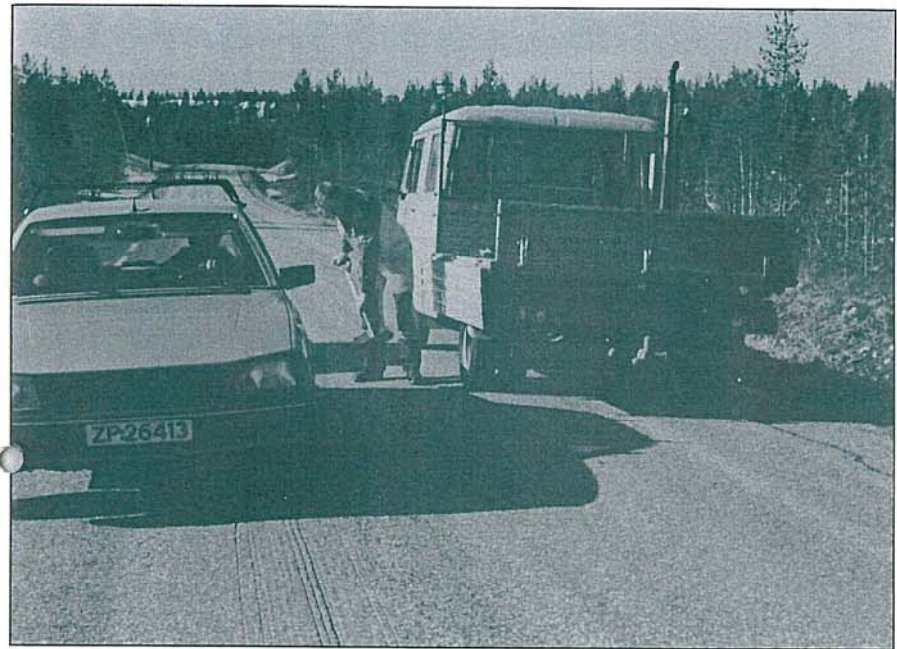
Ved vegarbeid er det mange som ikke setter ned farten og kjører alt for fort forbi. Det har ikke vært noen alvorlige ulykker i Finnmark til nå, men flere ganger har det vært nære på. (Illustrasjonsfoto: Torbjørn Mortensen)
