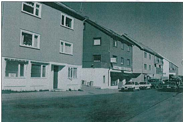
I Havnegaten i Vadsø er det flere boliger som nå får tilbud om støyisolerende vinduer. Statens vegvesen dekker alle utgifter til de nye vinduene, som vil være med og bedre innemiljøet. (Foto: Steinar Sverren)
