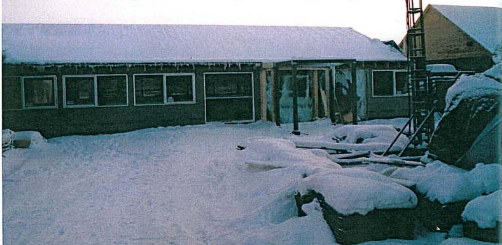
Behovet for nye lokaler er stort for personalet på trafikkstasjonen. Når trafikk samlokaliseres med produksjon på Sandnes skal førstnevnte folk inn i dette tilbygget.
