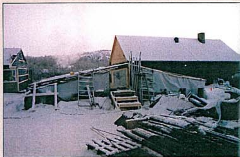
Dette ligner ikke på en kontrollhall, men i følge både planer og tegninger er det imidlertid det det skal bli. Når Reflexen besøkte Sandnes i februar så pågikk støpearbeidene under presenteringen for full.
