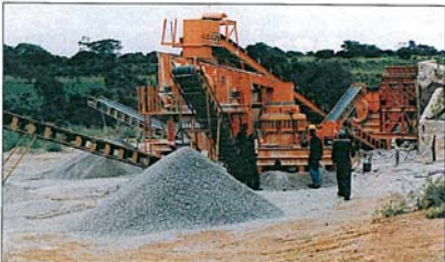
Når man bygger vei i Zambia må man være selvhjulpne på alle områder. Et eget knuseverk må til for å produsere den grusen som er nødvendig, og verket var derfor det første som sto klart når velbyggingen startet.
