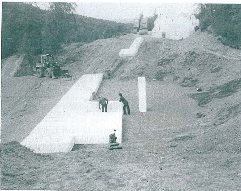
Dette bildet er tatt like etter at arbeidet med leggingen av isopor er kommet igang. Isoporblokkene stables opp i en høyde av 4 meter, og vegen bygges så opp på disse igjen med nye 4 meter med betongdekke og grusmasser.
