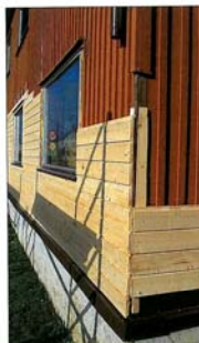
Gammelt panel skiftes ut med nytt. Ønsket om forandring gjør at mye godt materiale går tapt. Foto: Håkon B. Be
