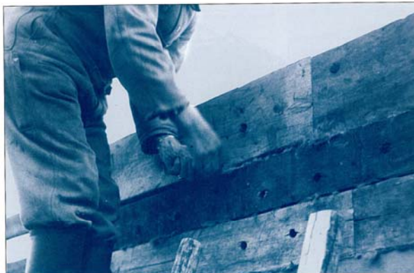
Her blir det brukt plank til lafting, stry og mose legges mellom som tetting. Foto: Angenell/Finmarkarkitektkontor, Vadsø
