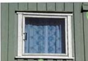
Dersom en velger å skifte ut det gamle vinduet, bør en som her erstatte det med et nytt vindu i samme størrelse. Foto: Randi Sjølie
