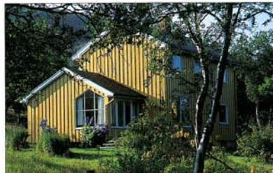
I Porsanger finner vi dette huset tegnet av Jens Selmer med tilbygg som er opprinnelig. Foto: Elisabeth Kongsbak
