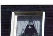
Ved etterisolering bør vinduene flyttes ut i veggene, og ikke som her forsvinne inn i veggene. Foto: Randi Sjølie
