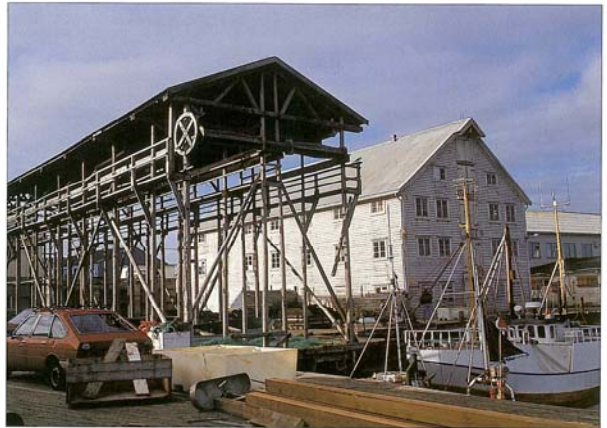
På Fjærtøftbruket i Berlevåg finner vi denne staselige nottjelta satt opp etter krigen. Hella er dobbelt med vandringer på hver side. Foto: Inger Unstad/Fylkeskonservatoren i Finnmark
