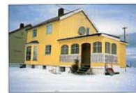
Mange gjenreisningshus har fått karnapp og tilbygg som i seg selv er fine, men endringene bidrar i liten grad til å framheve det opprinnelige bygget. Foto: Claug Thorveth
